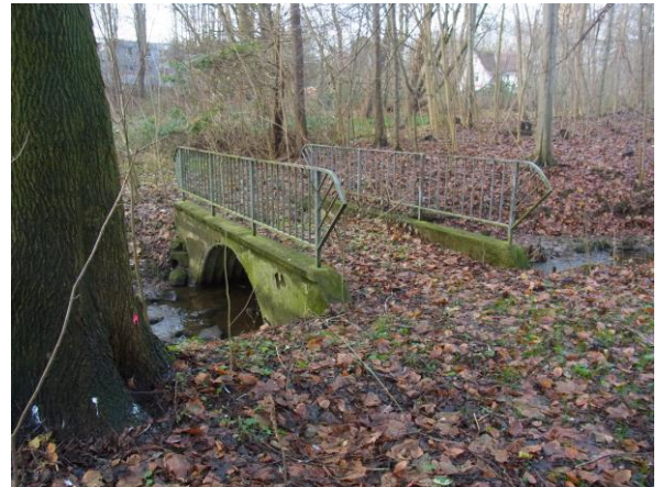
Brücke über den Mühlenbach
