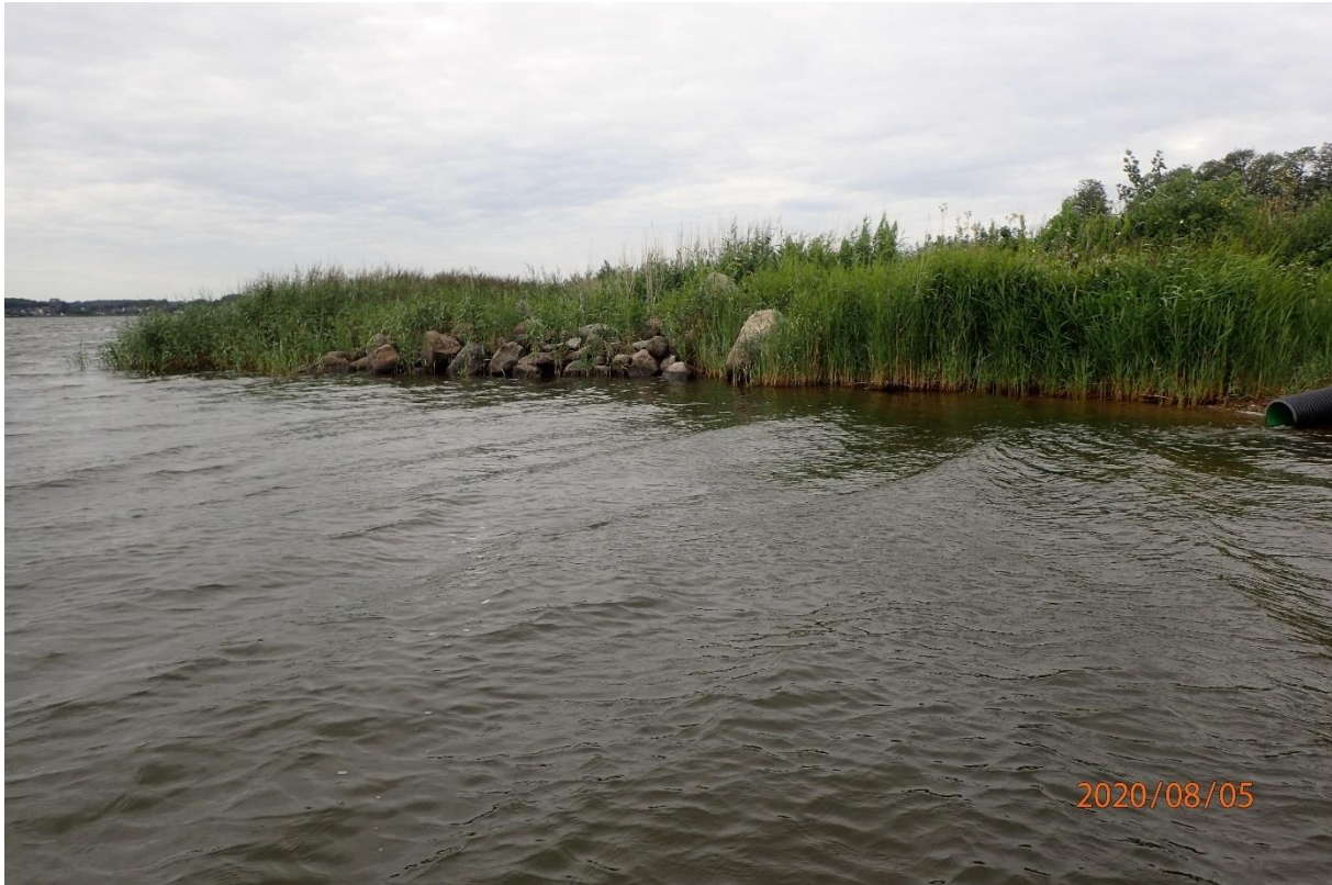
Abbildung 8: Blockaufschüttung und Entwässerungsrohr
