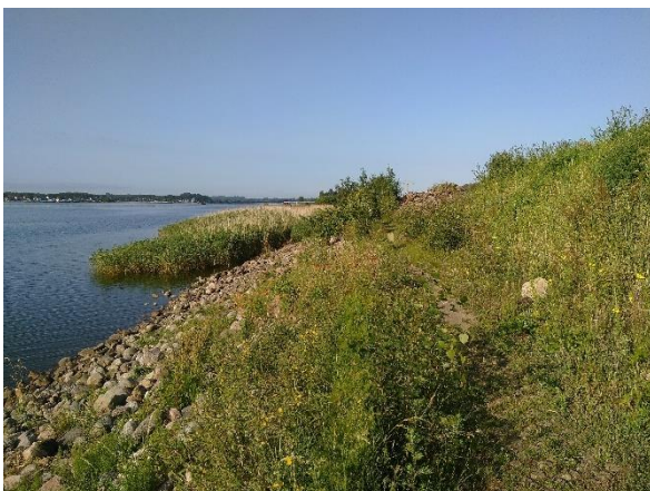
Foto 7: Blick auf die Steinschüttung am Schleufer mit Schilf-Brackwasserröhricht und angrenzender Nährstoffreicher Pionierflur und Ruderaler Staudenflur frischer Standorte mit Buschgruppen am 23.06.2020 (Blickrichtung Südwest).
