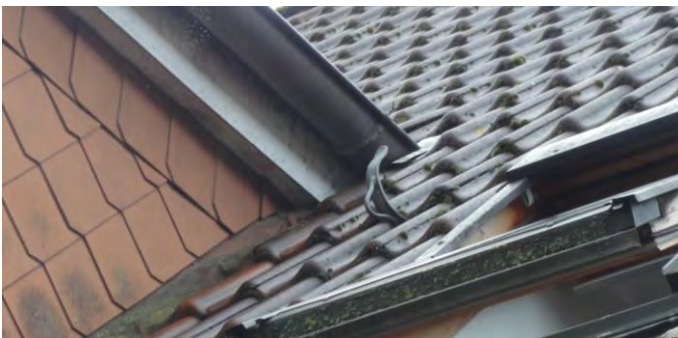
Abbildung 7: Dachziegel, Verkleidung und Regenrinne, Hausvorderseite
