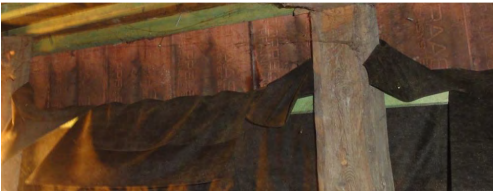
Abbildung 9: Folie unter Dachziegel
