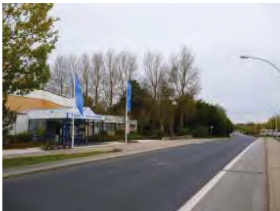
Abb. 6 Eingangsbereich der Schwimmhalle an der westlich Straßenseite der Friedrich-Ebert-Straße südlich des Vorhabengebietes (R. Pollok vom 05.10.2011)
