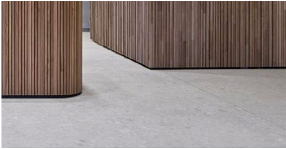
Fußbodenbelag Foyerbereich EG: Feinsteinzeug, großformatig
