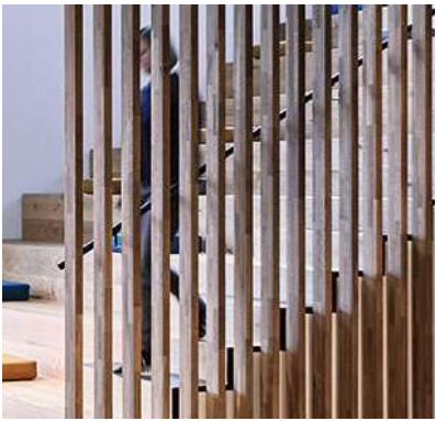
Leichte Trennung mit räumlicher Verbindung – Holzstäbe als gestalterisches Element zwischen Mittelzone und Treppe
